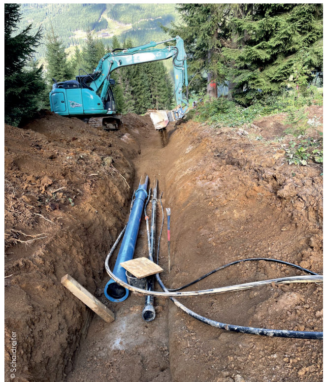
Parallel zur neuen Druckrohrleitung wurden in der Künette auch eine neue Schneileitung sowie Strom- und LWL-Kabel mitverlegt.
