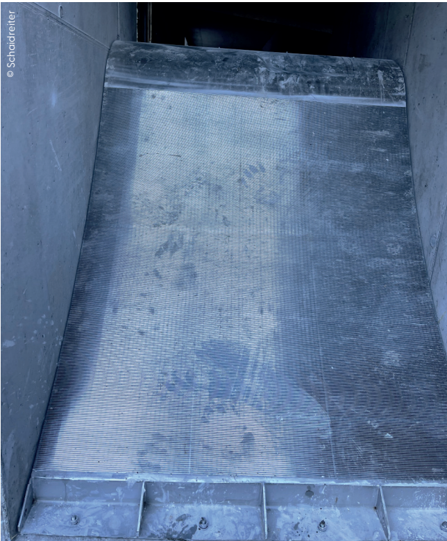
Der Ployergrabenbach ist bekannt für seine hohe Geschiebefracht. Daher wurde auf die Entsandung besonders großer Wert gelegt. GMT lieferte für die Fassung einen angepassten Coanda-Rechen.
