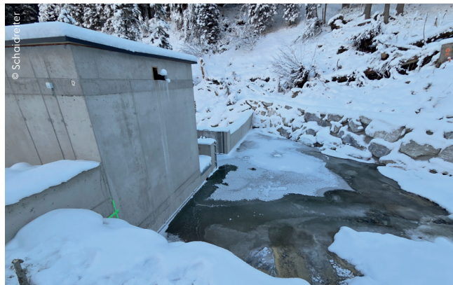
Ein eigener Wintereinlauf sorgt dafür, dass auch bei tiefwinterlichen Bedingungen an der Wasserfassung Triebwasser eingezogen wird.
