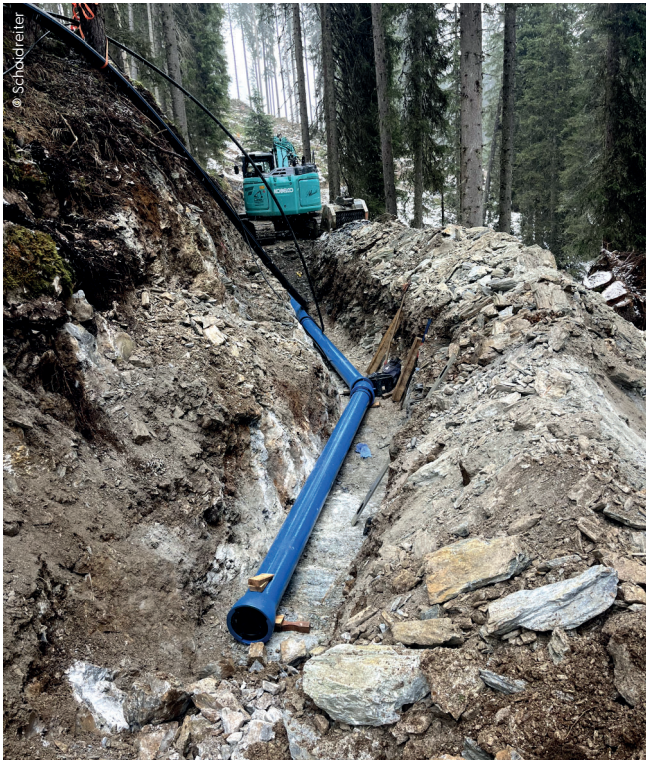
Die Hänge des Ployergrabens gelten als stark hydromorph und geologisch instabil. Umso wichtiger war es, dass die gesamte Druckrohrleitung schub- und zugesichert ausgeführt wurde.
