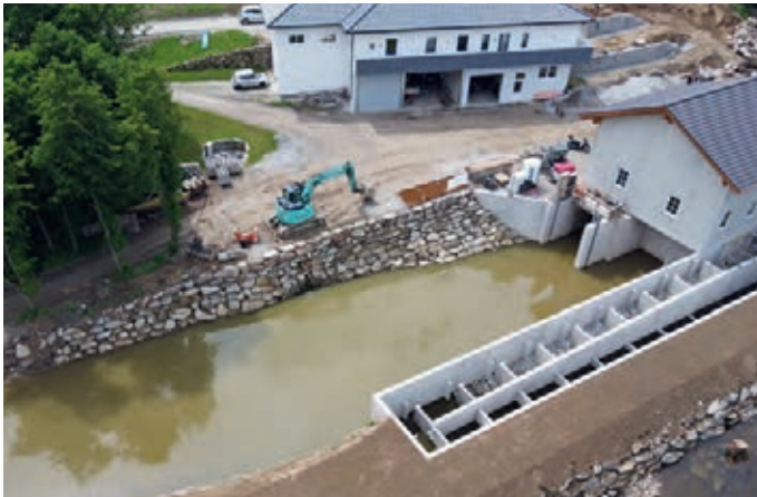
Die Fischaufstiegshilfe wurde mithilfe von Betonfertigteilen erstellt. Sie wird den Bewohnern der Großen Mühl ein problemloses Passieren der Anlage ermöglichen.
