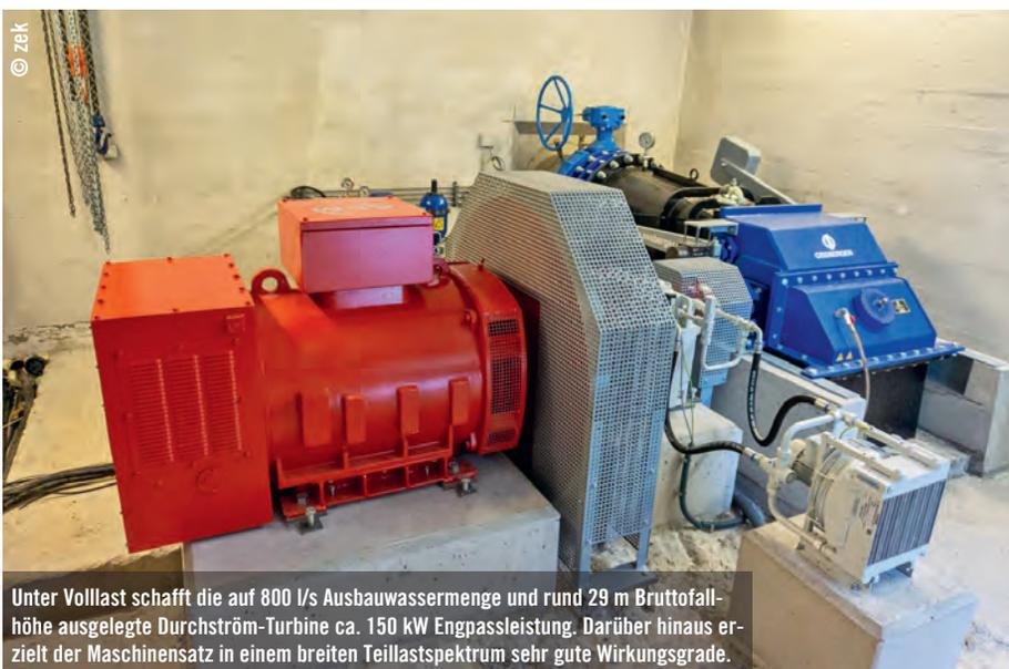
Unter Vollast schafft die auf 800 l/s Ausbaumassermenge und rund 29 m Bruttofallhöhe ausgelegte Durchström-Turbine ca. 150 kW Engpassleistung. Darüber hinaus erzielt der Maschinensatz in einem breiten Teillastspektrum sehr gute Wirkungsgrade.
