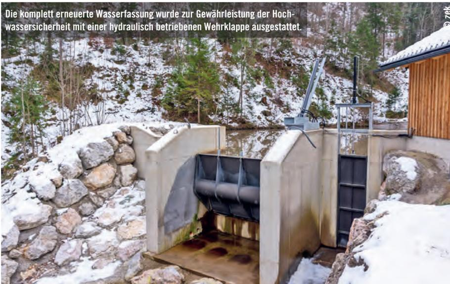
Die komplett erneuerte Wasserfassung wurde zur Gewährleistung der Hochwassersicherheit mit einer hydraulisch betriebenen Wehrklappe ausgestattet.
