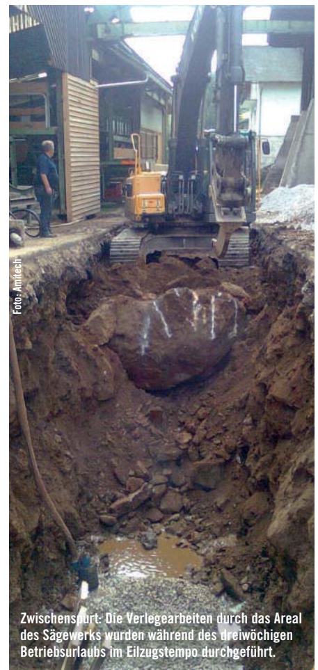
Die Rohrleitung wurde in bis zu 6 Metern Tiefe verlegt, am Areal des Sägewerks in 5 Meter Tiefe.
