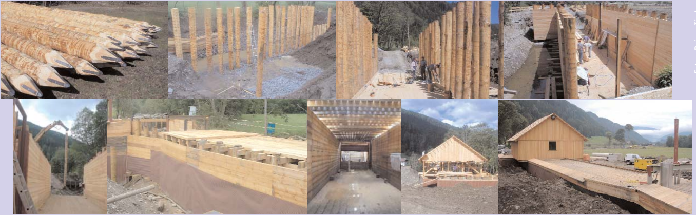
Mit dem nötigen Know-how lässt sich auch aus Holz ausgezeichnet eine Entsandungsanlage bauen. Die Konstruktion aus Lärchenholz hält ebenso lange wie ein Betonbau.
